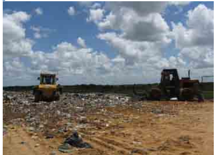
Figura 15 – Aterro Sanitário de Massaranduba em Ceará-Mirim, RN
